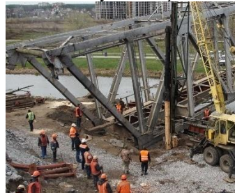
Рис. 3 – Процес відновлення моста лівої колії
