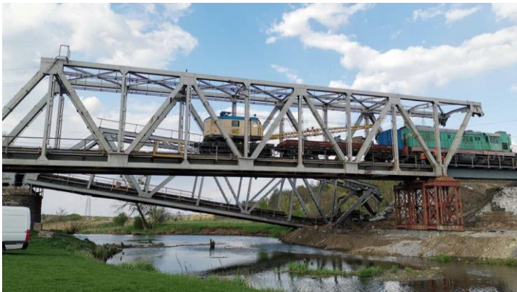
Рис. 4 – Тимчасово відновлений міст лівої колії
