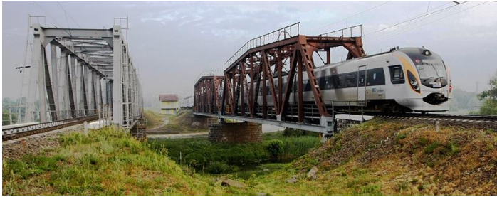
Рис. 1 – Мости через р. Ірпінь, вигляд по ходу кілометрів
